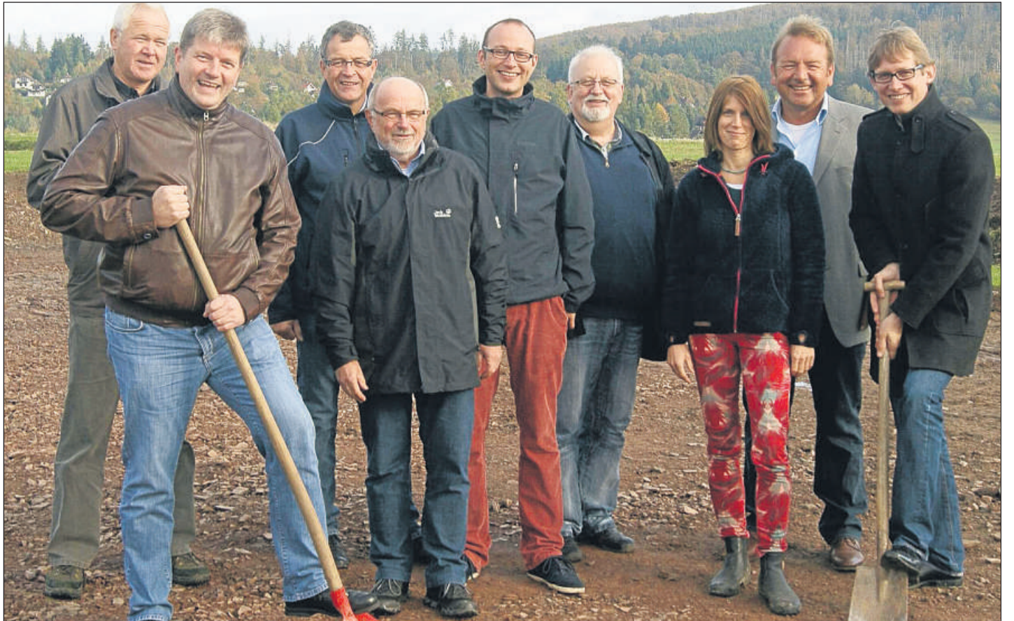
Der Anfang ist gemacht: Über den Startschuss zum Bau der Kultur-Arche in Frankenu freuen sich (von links) Bauunternehmer Gerhard Freitag, Bauamtsleiter Thomas Tönges, Bauunternehmer Ullrich Mütze, Herbert Müller vom Arche-Verein, Projektmanager Lutz Schmithausen, Hans-Wilhelm Mutter vom Architekturbüro Suck, Sandra Uffelmann, Architekt Karl Suck und der Erste Kreisbeigeordnete Jens Deutschendorf.
